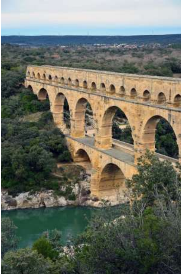
Ryc191. Rzymski akwedukt Pont du Gard, 48m., 50, Francja
